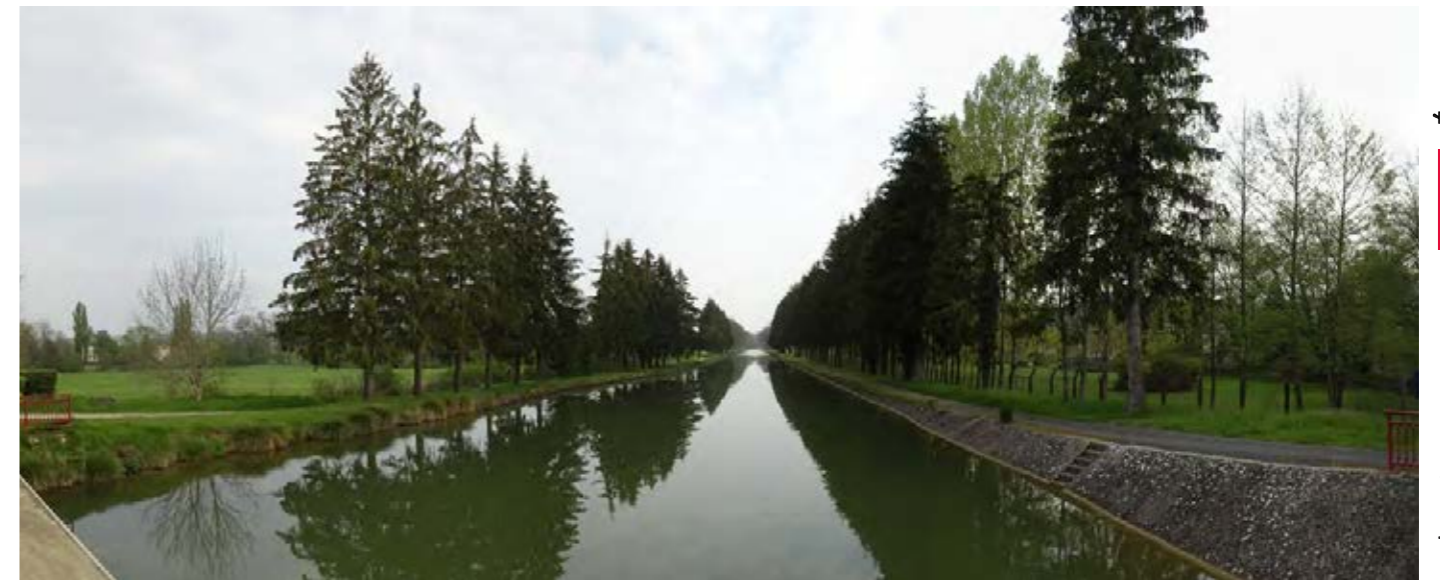
Photo 4 : Vue sur le canal de la Saône à la Marne à proximité de Vraincourt et Viéville (@ Agence couasnon)
